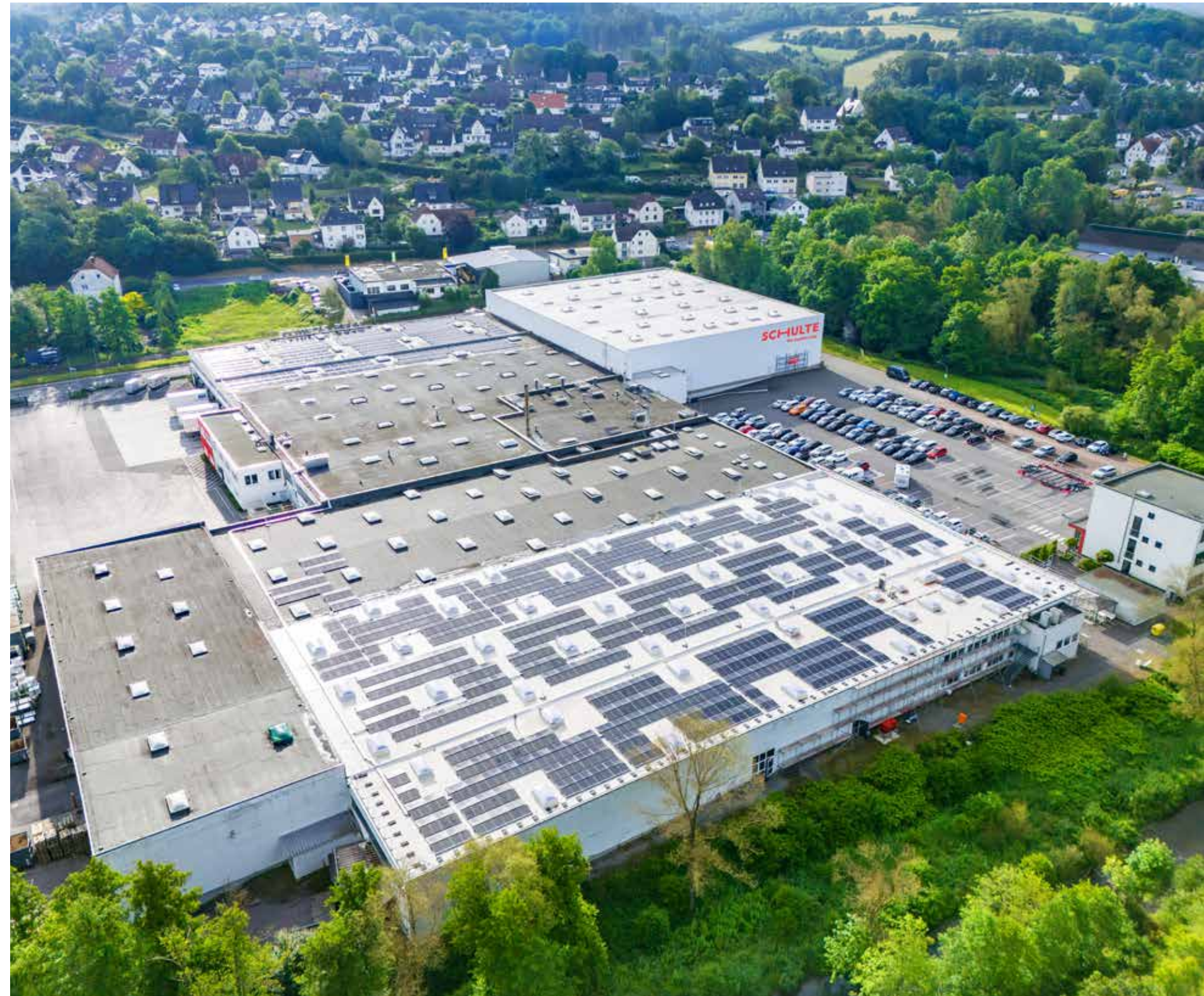
Das Werk Gebr. Schulte GmbH & Co. KG im Industriegebiet Zum Dümpel in Sundern – Sauerland, PV-Anlage auf dem vorderen Gebäude
